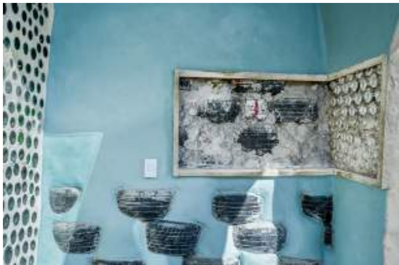
Figura 8: Uso de materiales reciclados en la escuela sostenible Mar Chiquita. Fuente: iF Design, 2021
